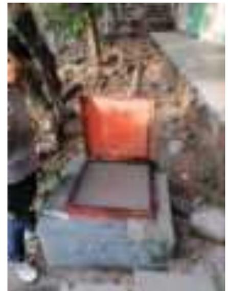
Se realizaron trabajos de reparación y reposición de conexión eléctrica para los edificios G y J, los cuales fueron afectados por robo, así mismo se realizó un sellado de tapas de las tuberías con concreto hidráulico a efecto de mantener protegidas las conexiones.
