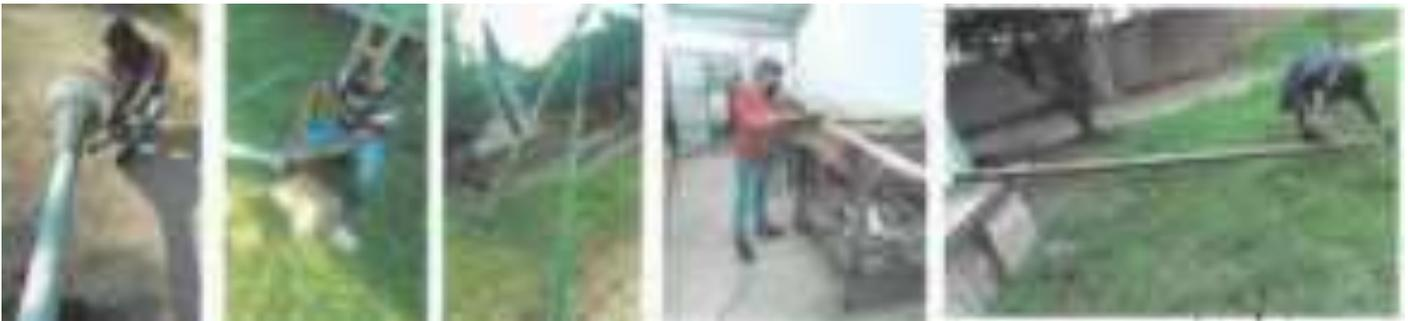
Para la distribución de agua en nuestras instalaciones, se realizó el cambio de 25 metros de tubería de la toma principal de agua potable.
